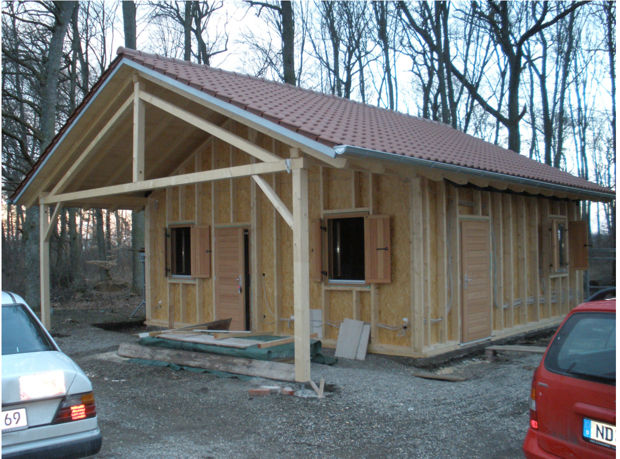
Das "Haus am See" in der Bauphase
